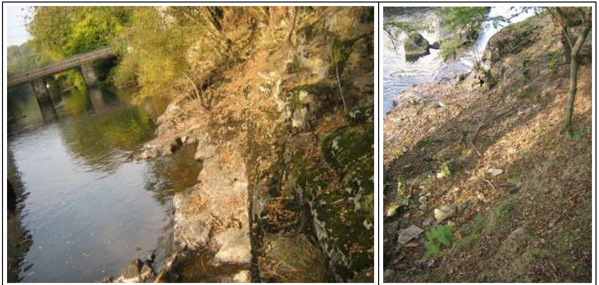
Figure 4-2 : détails de l'érosion en rive droite.
