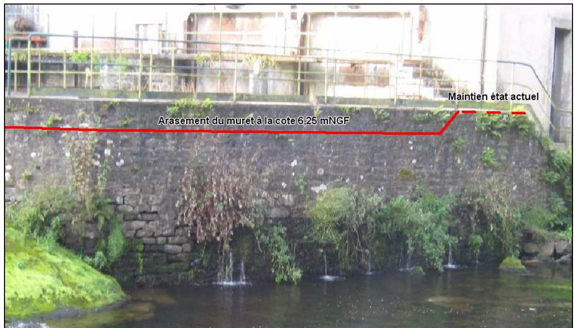
Figure 4-4 : principe d'arasement du muret du moulin.
