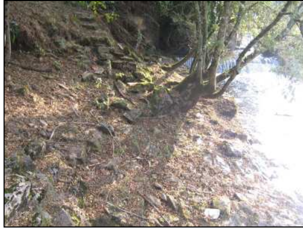
Figure 4-1 : ruines du mur de soutènement de la berge rive droite.
