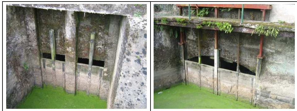
Figure 4-3 : vues des deux vannages du moulin condamnée.
