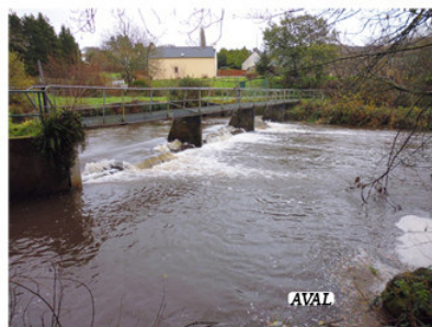
ANCIENNES GRILLES DE GUIDAGE ABAISSEES ET NOYEEES (F. MOALIC, 07/12/2017)
