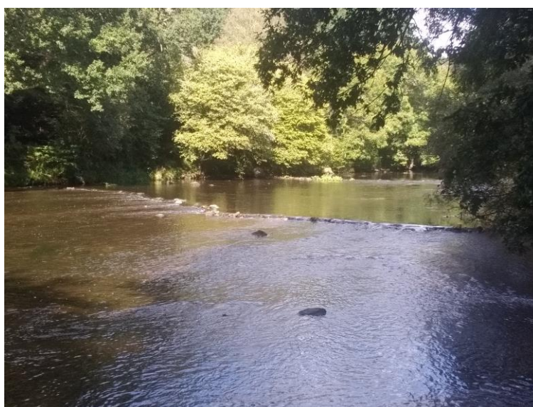
Figure 32 : vue de la station Ellé_2 (seuil en pierres)
